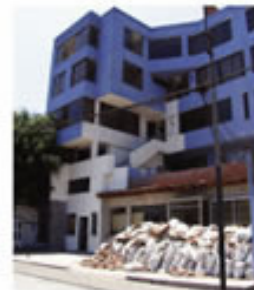
Edificio inhabitable en Av. Javier Prado Este N° 1234 - A
