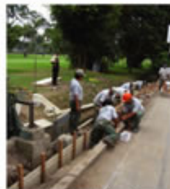
Inicio de los trabajos de la vereda.
