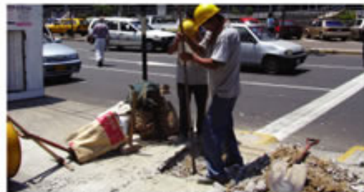
Trabajos de instalación en el cruce de Aramburú con Petit Thouars.
