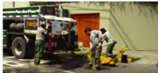
Equipo de mantenimiento de vías en faenas interrumpidas.
