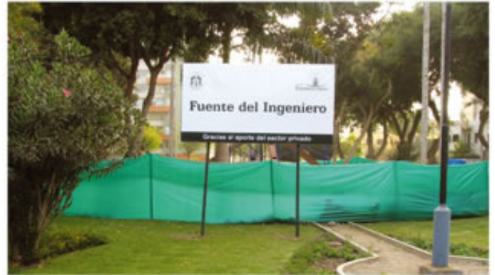
Fuente del Ingeniero en ejecución. Banco de Crédito, la UPC y TACA, son los próximos Vecinos Comprometidos.
