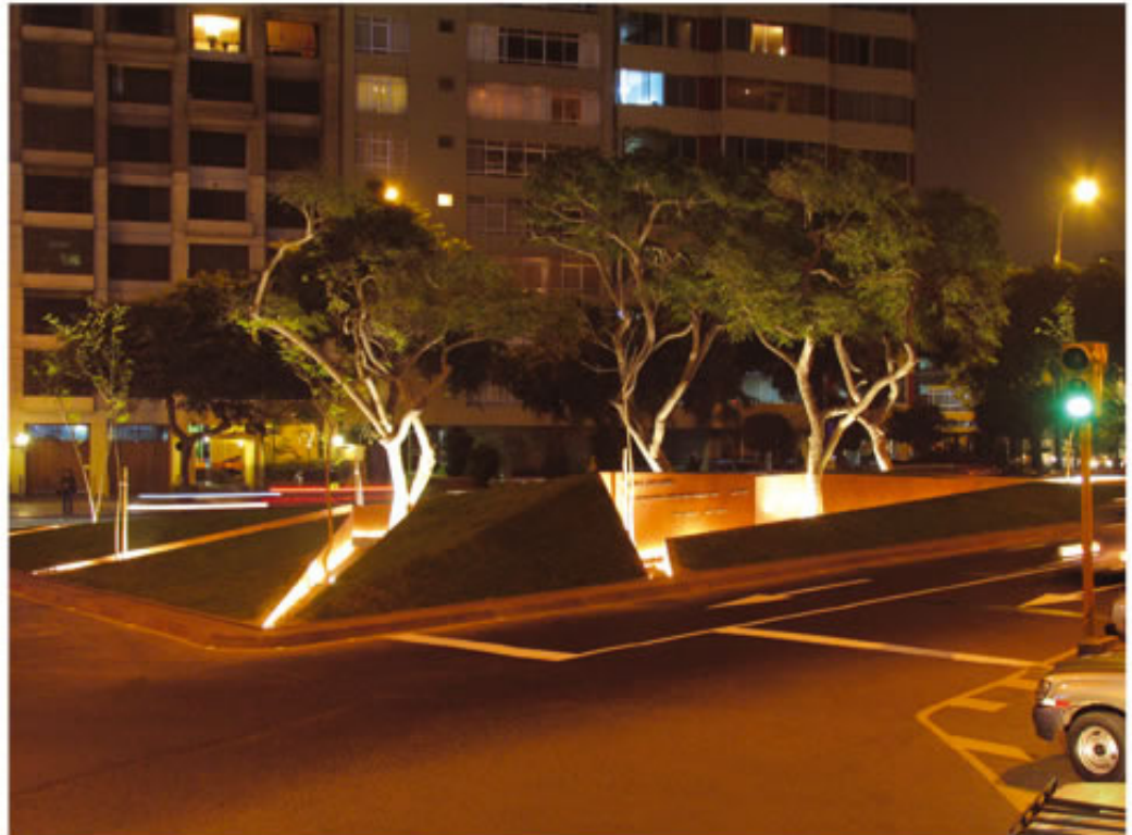
La obra ha permitido que se duplique la cantidad de áreas verdes en la zona, aportando seguridad gracias a casi 170 luminarias.
