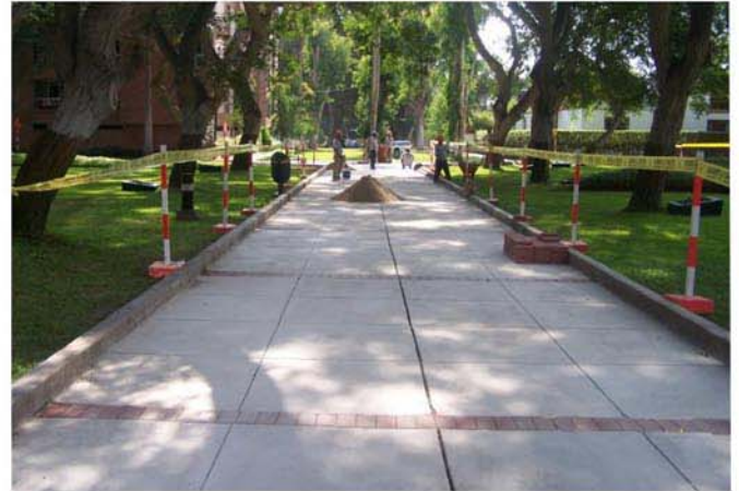
Parque Roosevelt. Mantenimiento de veredas con concreto premezclado y adoquines de concreto de color (sector 2).
