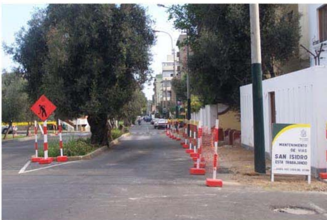
Calle La República Cdra. 3. Construcción de veredas y martillos con concreto premezclado (sector 3).
