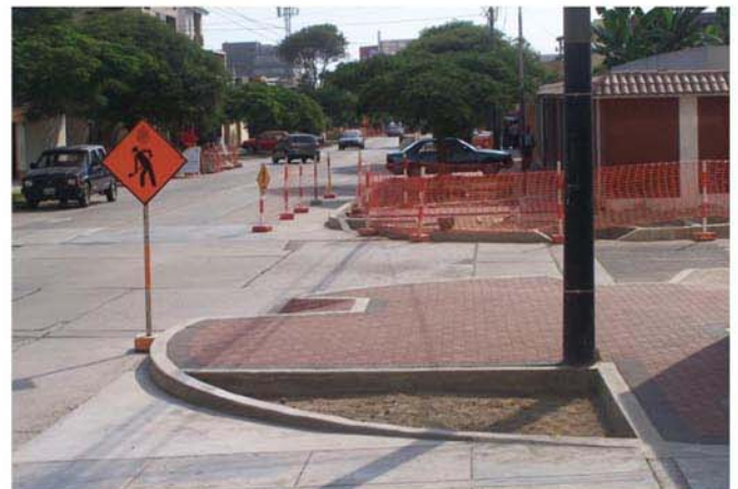
Calle 32. Construcción de crucesos peatonales modernos y seguros, reparación de calzada, veredas, sardineles y recuperación de bermas con áreas verdes (sector 5).
