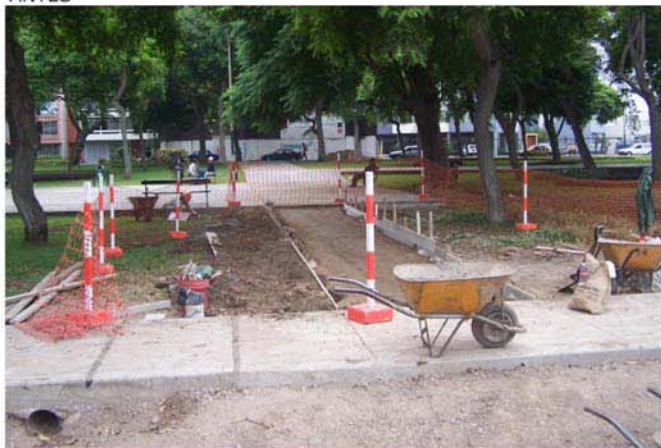
Parque Mora. Construcción de sardineles en bermas, eliminando el parqueo y recuperando las áreas verdes. Mantenimiento de veredas con concreto premezclado (sector 2).
