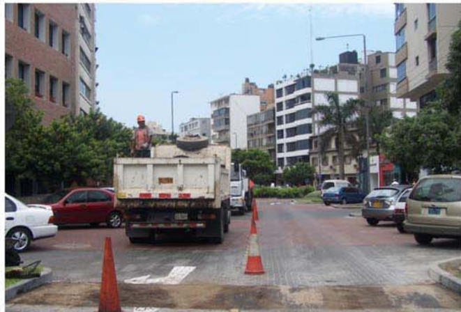
Construcción de gibas con mezcla asfáltica en caliente en la Av. Miguel Dasso intersección con la Av. Álvarez Calderón y en la Calle Norberto Eléspuru intersección con la Calle Los Manzanos.
